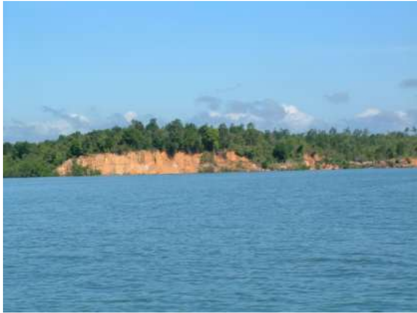
Foto 6. Kerusakan hutan disekitar areal rumput laut menyebabkan terjadinya longsor yang membawa sedimentasi ke laut
